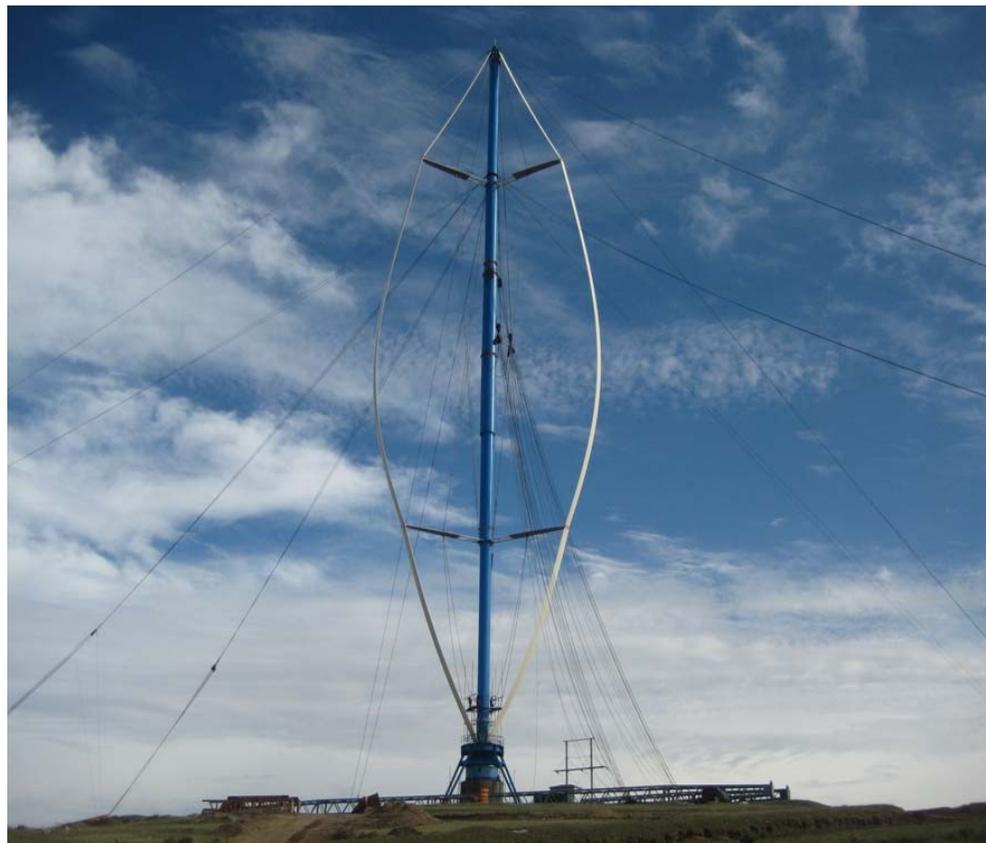
Прототип вертикальной станции GWI - 1,500 kW - Urumuqi
