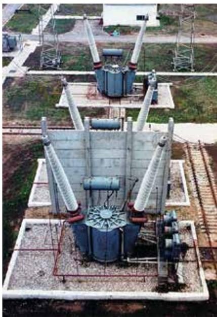
Рис. 3. Шунтирующий реактор для ВЛ 1150 кВ на испытаниях
