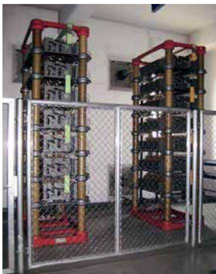
Рис. 5. Фото ВТВ 35 кВ первого и второго поколений
