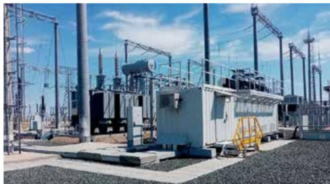
2022 г. УШРТ 30 Мвар 220 кВ для стабилизации напряжения и компенсации зарядной мощности линии 220 кВ.
