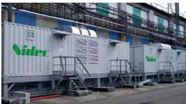
2022 г. СТАТКОМ+ФКЦ 8 Мвар 6 кВ для компенсации реактивной мощности и фильтрации гармоник
