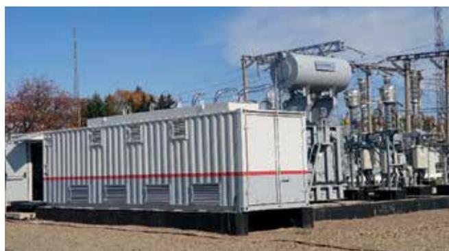
2023 г. УШРТ 25 Мвар 110 кВ для стабилизации напряжения и компенсации зарядной мощности линии 110 кВ
