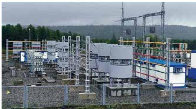
2021 г. СТК 20 Мвар 10 кВ для симметрирования напряжения и фильтрации высших гармоник от внешней сети 110 кВ
