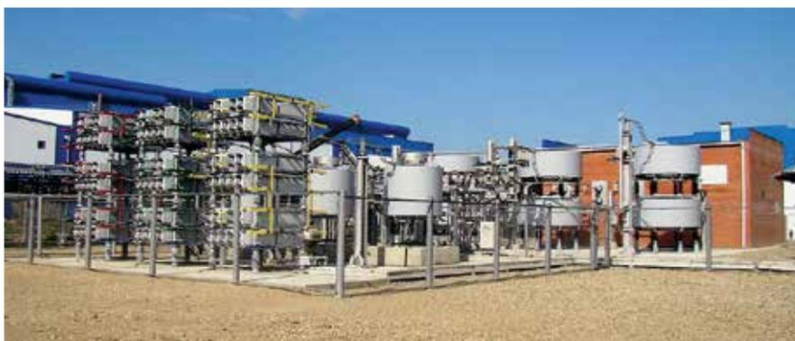
Рис. 7. ООО «АЭМЗ», г. Абинск, СТК 35 кВ 180 Мвар для ДСП 130 МВА и АПК 24 МВА
