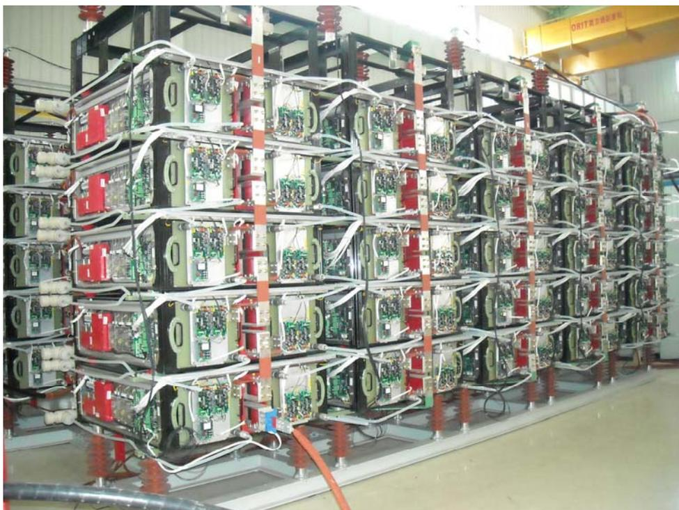
Рис. 7. Фото одной фазы преобразователя
