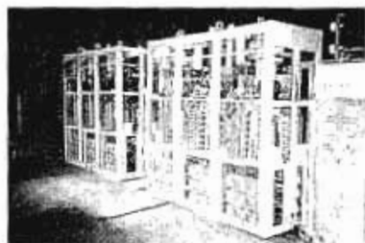
Рис.4. Тиристорный преобразователь частоты с водяным охлаждением для двигателя мощностью 6300 кВт на напряжение 2 кВ
