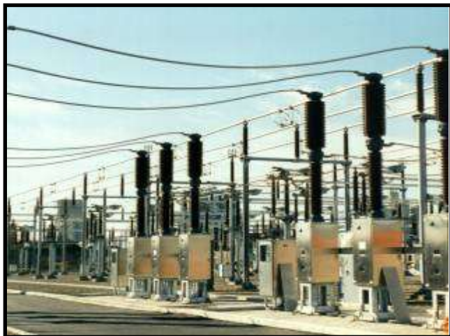
ВВ распределительные устройства Внешняя установка
