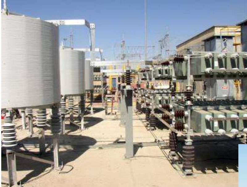
Статические тиристорные компенсаторы (СТК) Фильтрация гармоник и Компенсация
