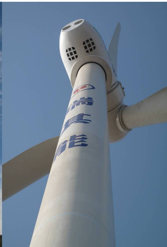
Прототип станции Weifang 1,600 kW - Qindao
