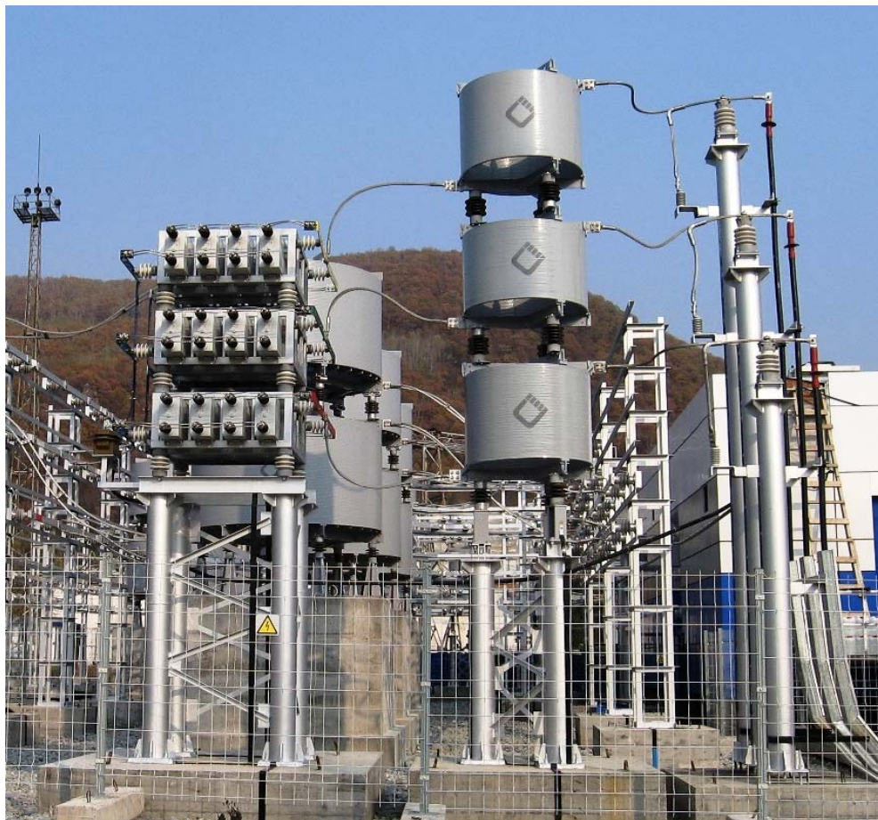
Рис. 4. Фильтрокомпенсирующая цепь
