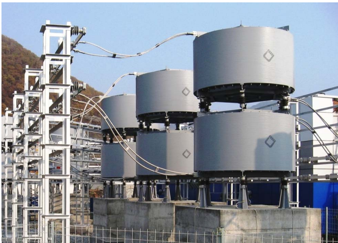
Рис. 3. Компенсирующие реакторы
