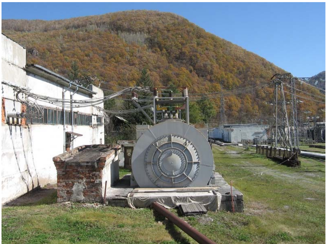
Рис. 10. Синхронный компенсатор на ПС Горелое
