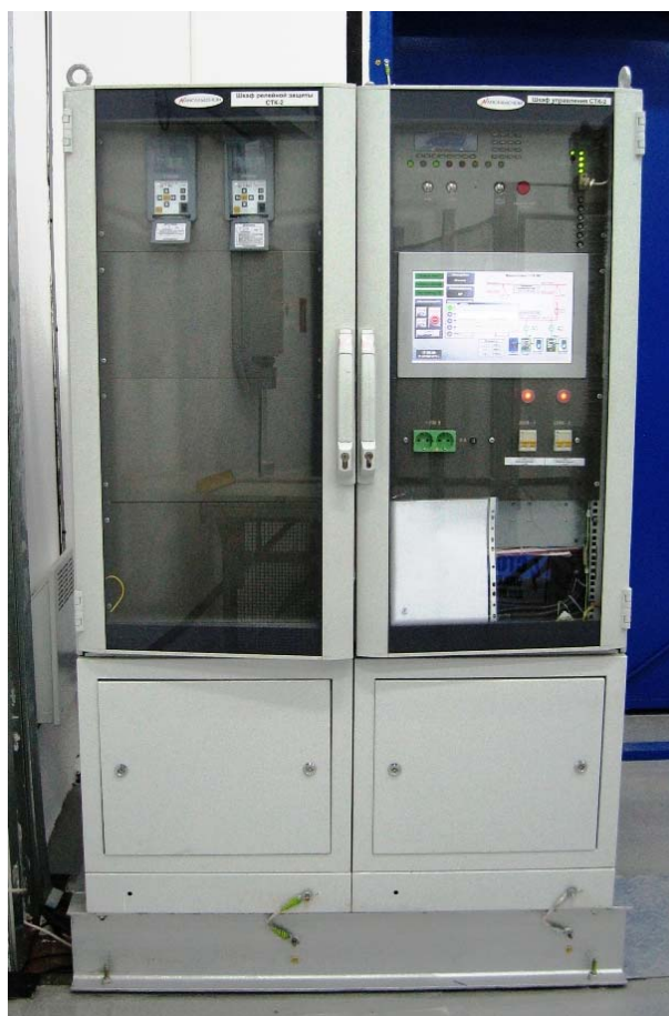
Рис. 5. Система управления СТК (ШРЗ и ШУ)
