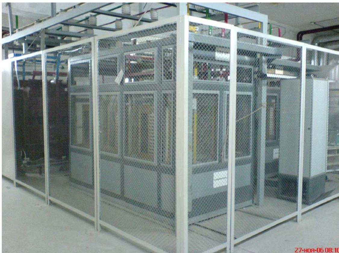
Рис. 2. Тиристорное пусковое устройство на объекте
