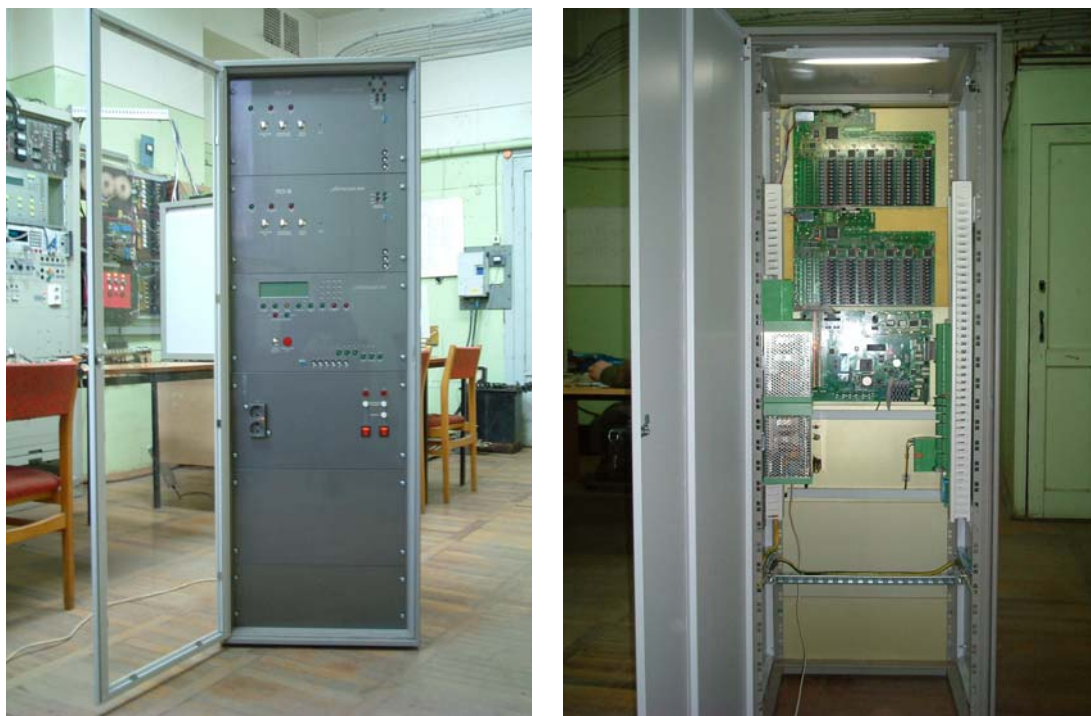
Рис.4. Шкаф управления ТПУ (вид спереди и сзади с открытой дверью)
